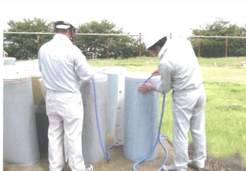
2.給水施工状況
