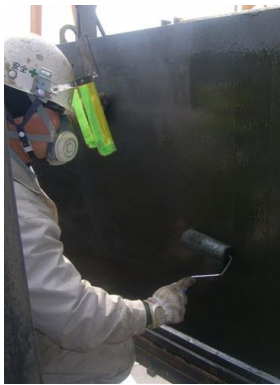
BOX剥がし施工例
