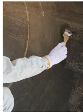
ヒューム管剥がし施工例
