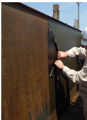
BOX剥がし施工例
