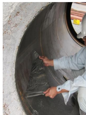
ヒューム管剥がし施工例
